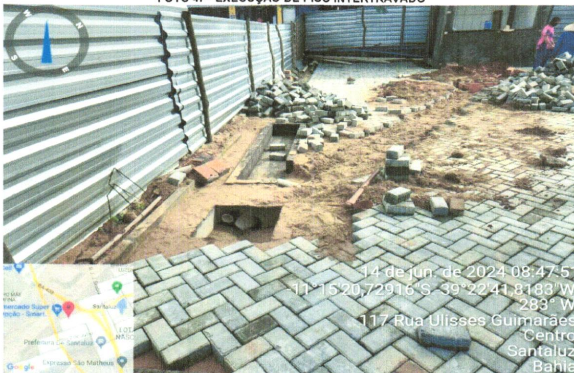
FOTO 48- EXECUÇÃO DE PISO INTERTRAVADO
