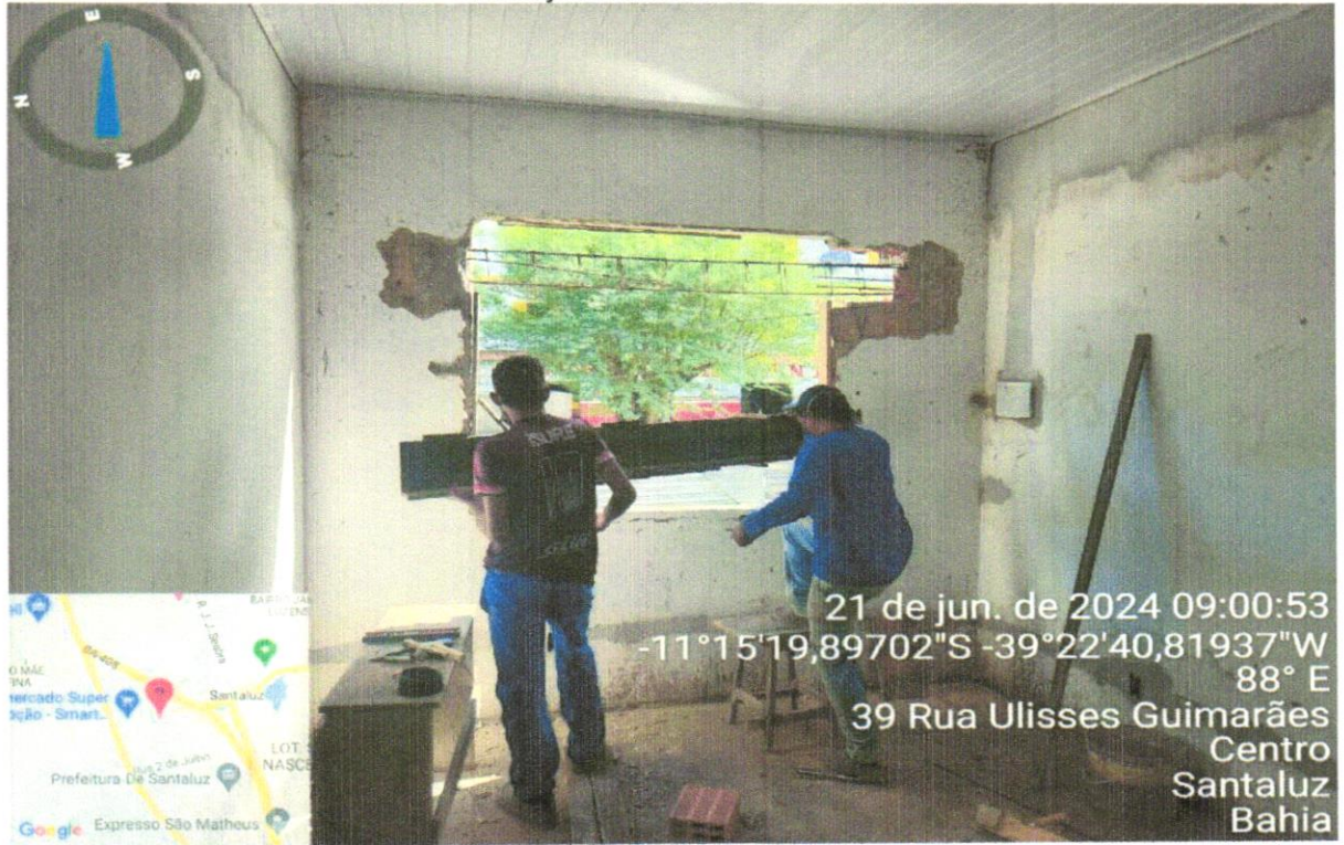
FOTO 16 – EXECUÇÃO DE ESQUADRIA PARA JANELA
