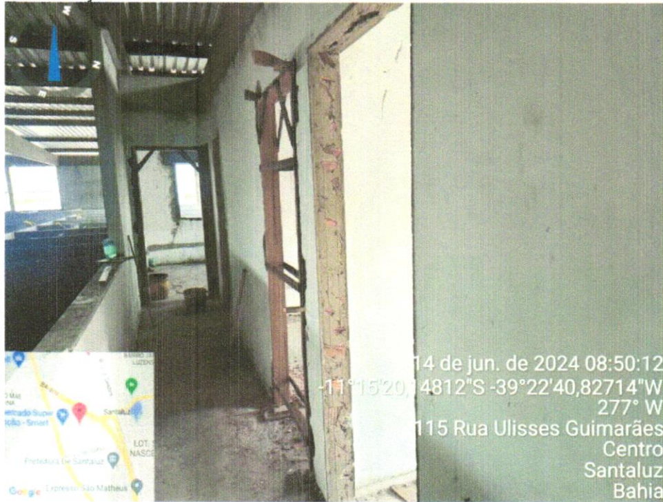
FOTO 02 – INSTALAÇÃO DE KIT DE PORTA DE MADEIRA PARA PINTURA SEMI-OCA
