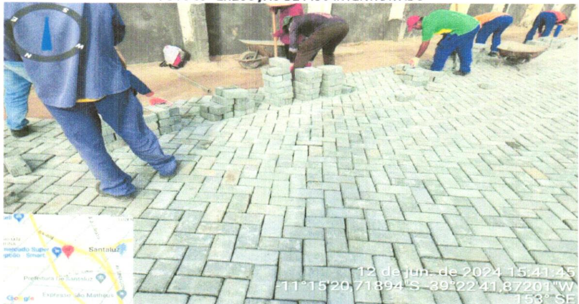
FOTO 38- EXECUÇÃO DE PISO INTERTRAVADO
