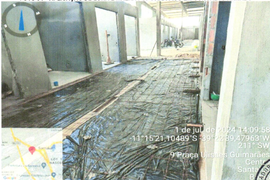
FOTO 04 – APLICAÇÃO DE LONA E MALHA POP PARA PISO EM CONCRETO ARMADO
