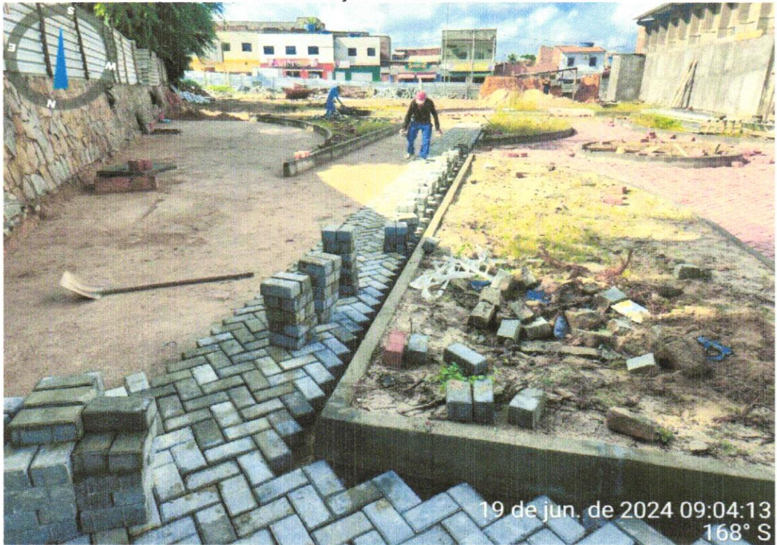
FOTO 34- EXECUÇÃO DE PISO INTERTRAVADO
