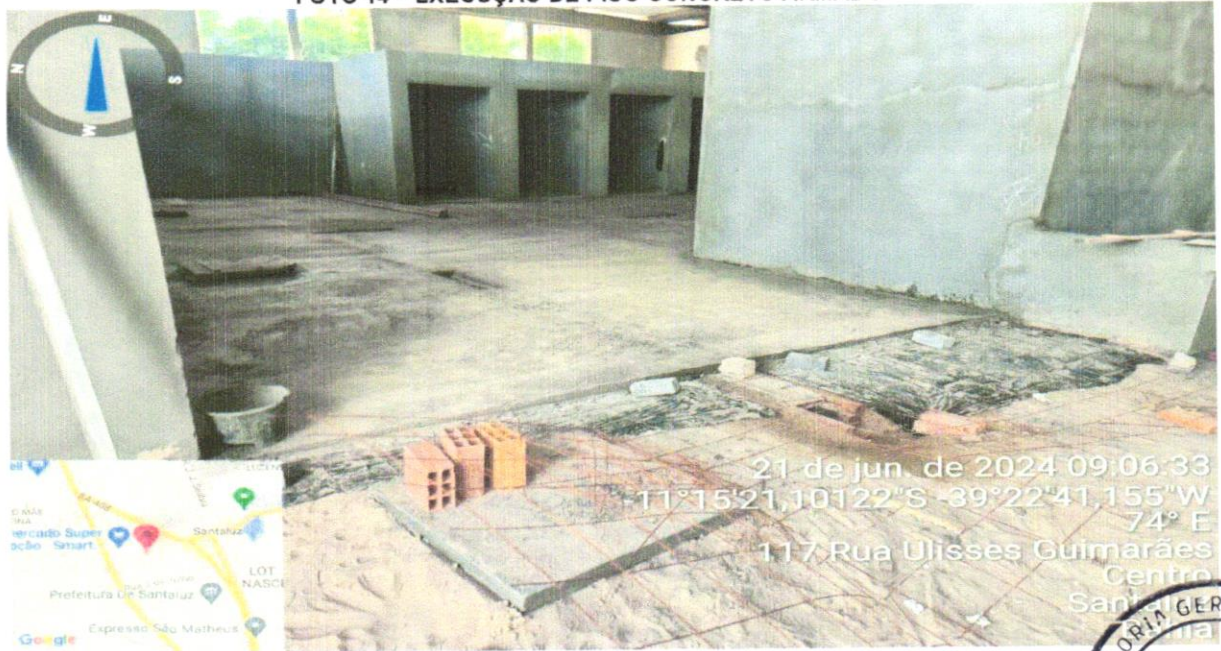
FOTO 14 – EXECUÇÃO DE PISO CONCRETO ARMADO
