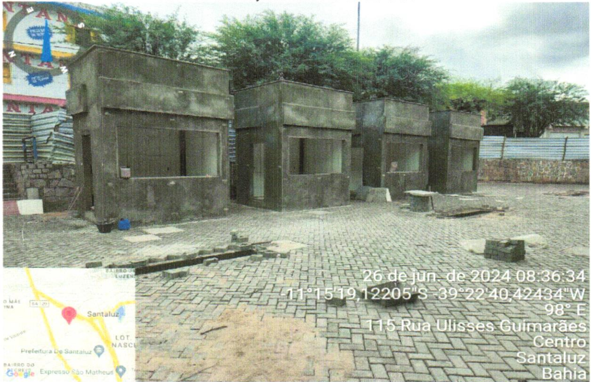
FOTO 42- EXECUÇÃO DE PISO INTERTRAVADO
