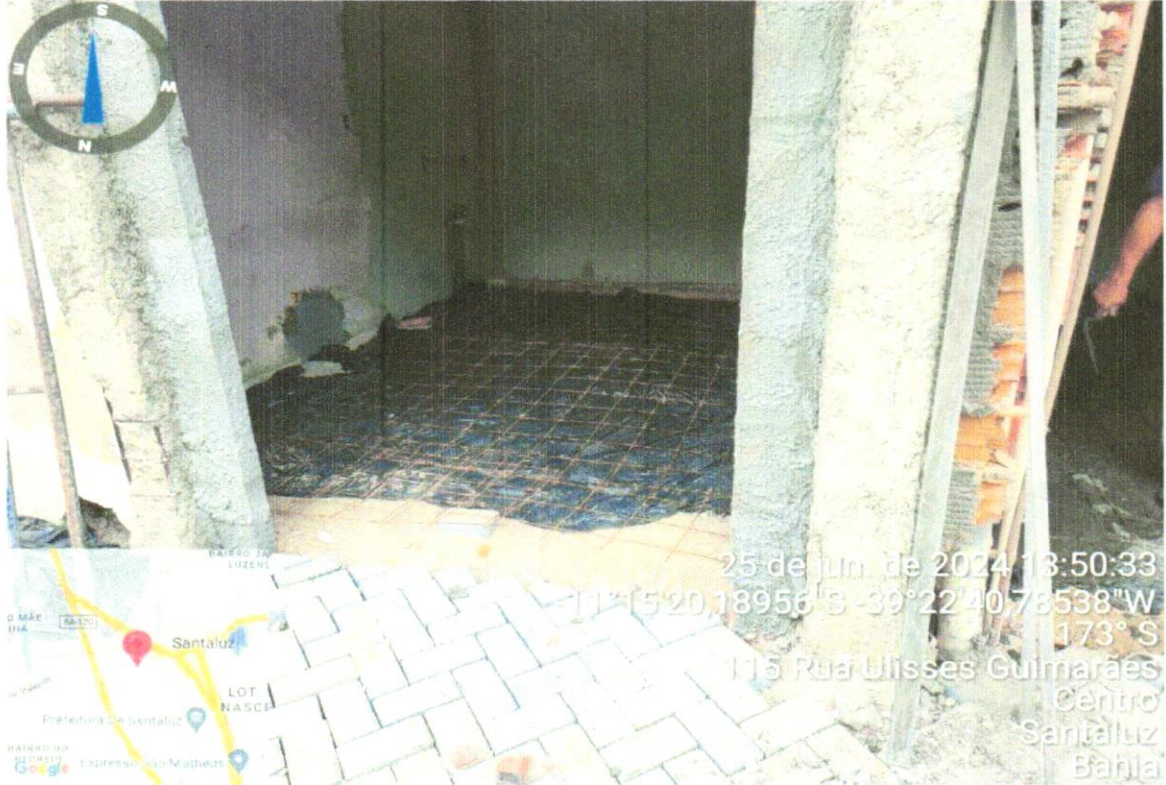
FOTO 08 – APLICAÇÃO DE LONA E MALHA POP PARA PISO EM CONCRETO ARMADO
