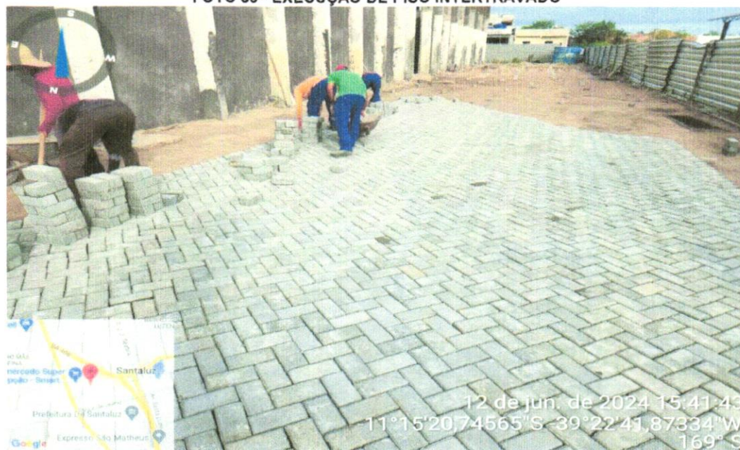
FOTO 36- EXECUÇÃO DE PISO INTERTRAVADO
