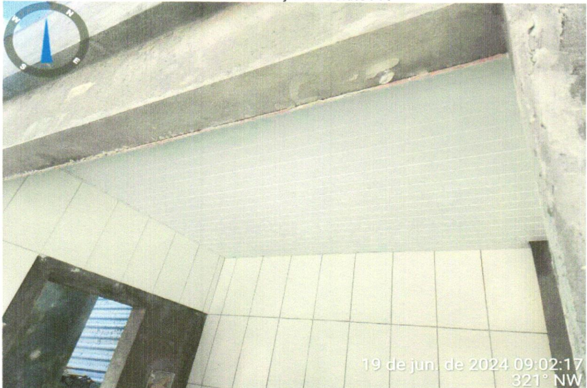
FOTO 24 - EXECUÇÃO DE FORRO PVC
