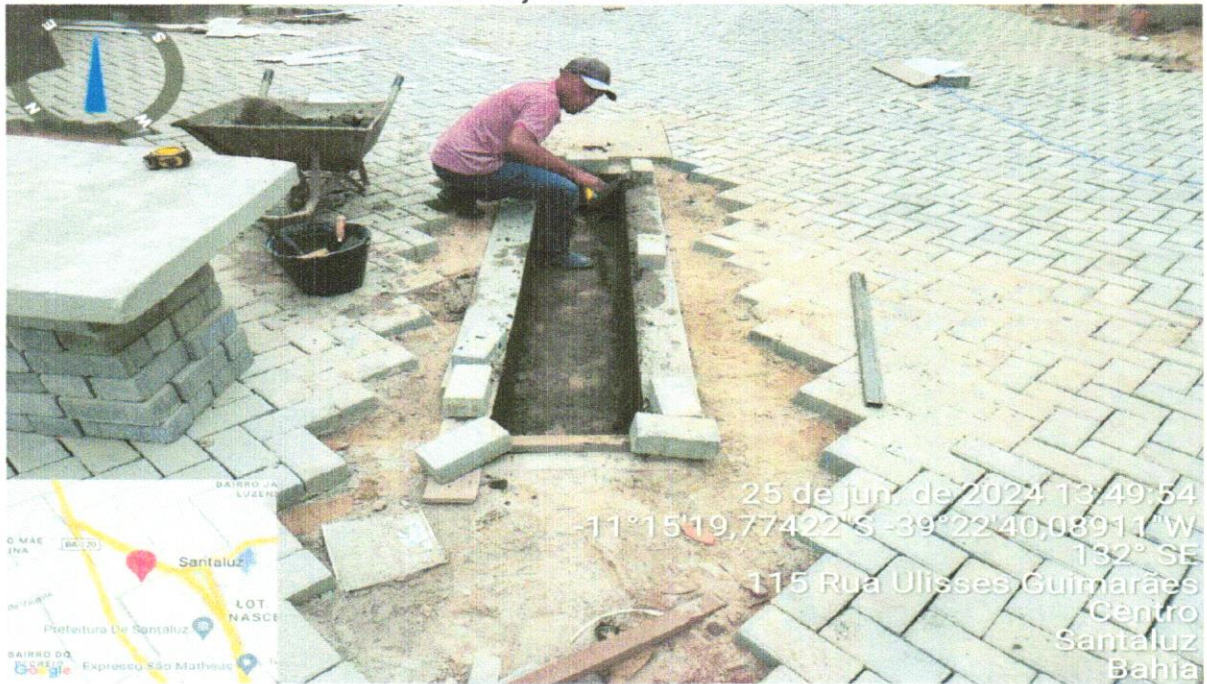
FOTO 44- EXECUÇÃO DE PISO INTERTRAVADO
