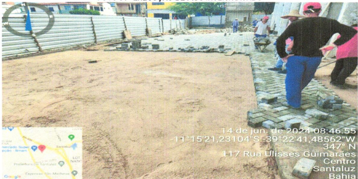
FOTO 34- EXECUÇÃO DE PISO INTERTRAVADO
