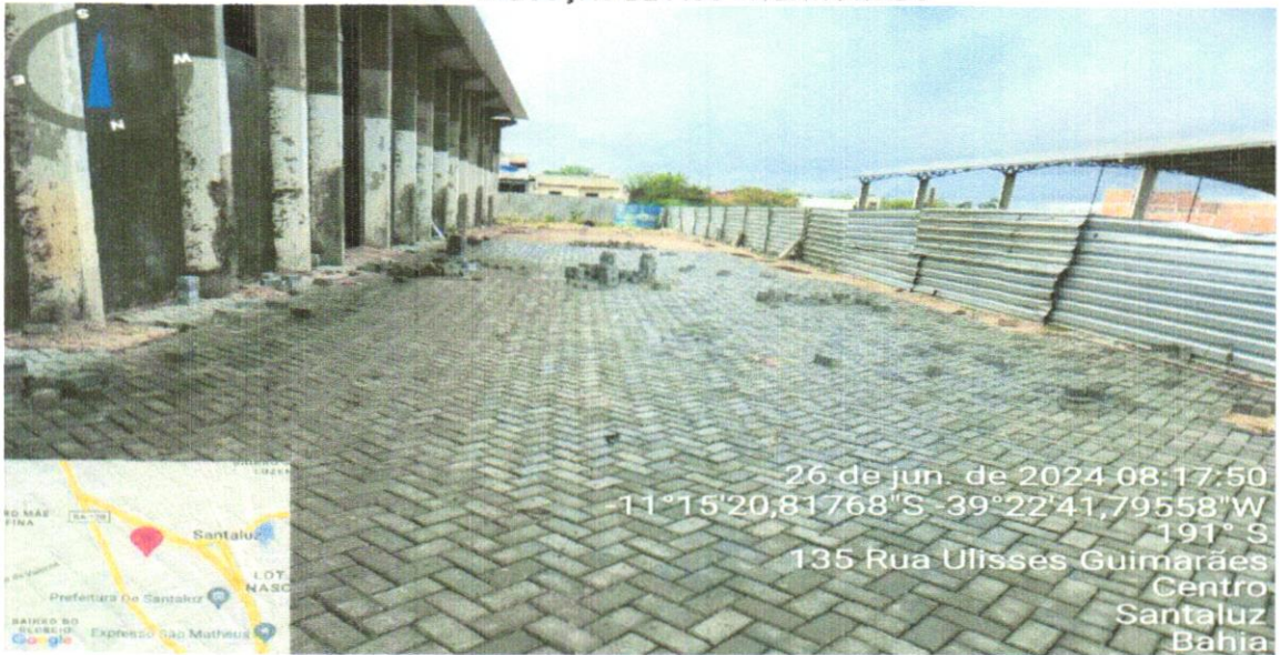
FOTO 40- EXECUÇÃO DE PISO INTERTRAVADO
