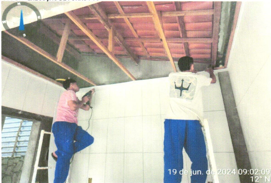
FOTO 22 – EXECUÇÃO DE FORRO PVC
