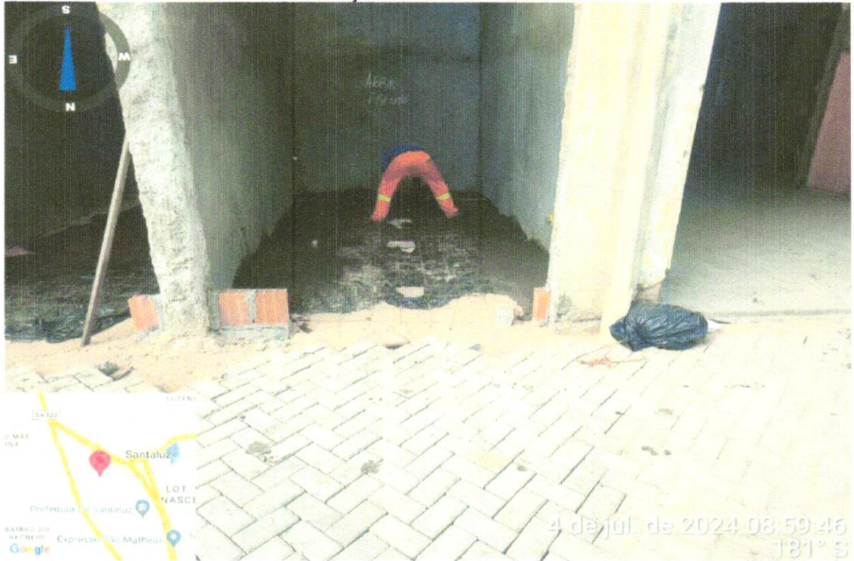
FOTO 12 – EXECUÇÃO DE PISO CONCRETO ARMADO
