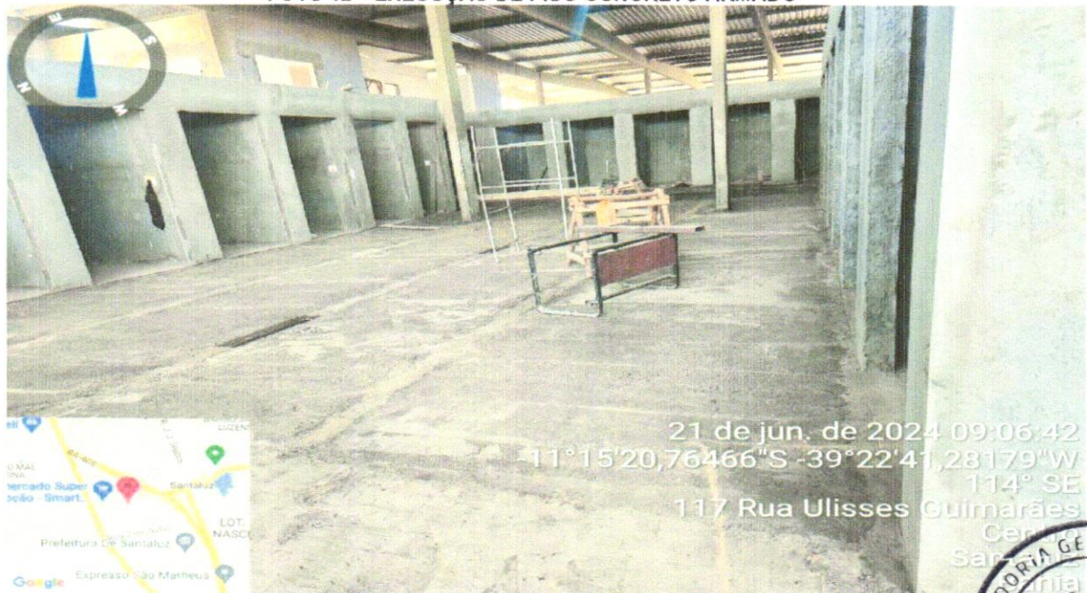
FOTO 12 – EXECUÇÃO DE PISO CONCRETO ARMADO
