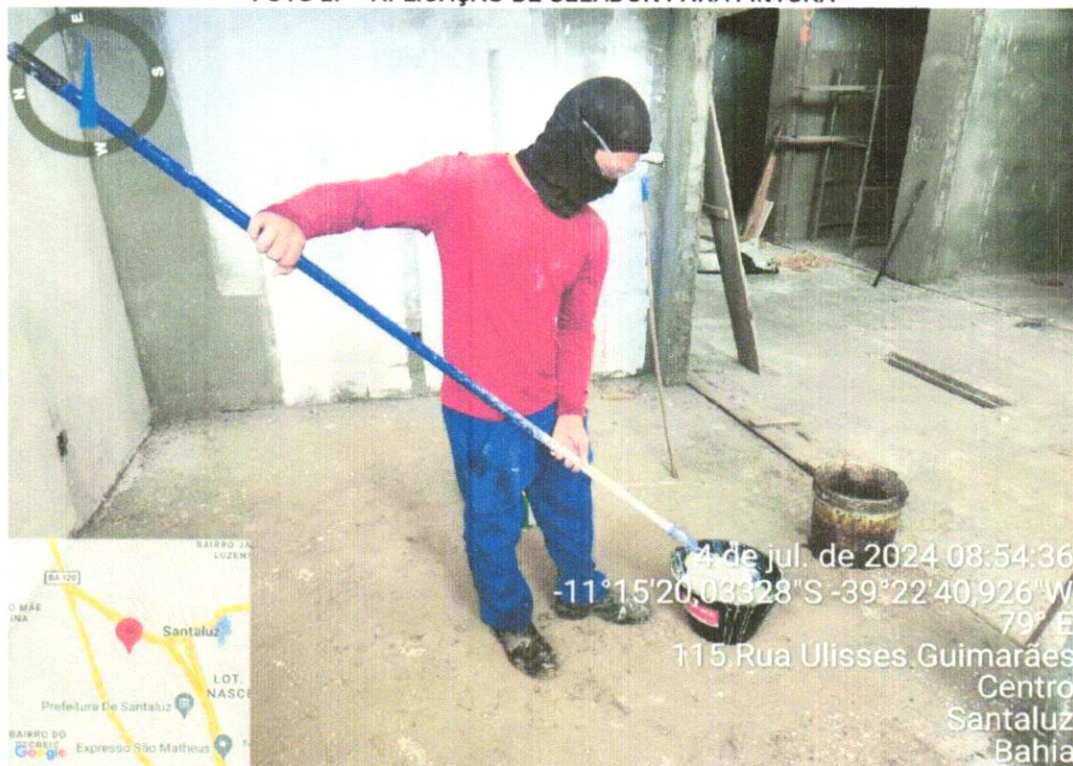
FOTO 28 – APLICAÇÃO DE SELADOR PARA PINTURA
