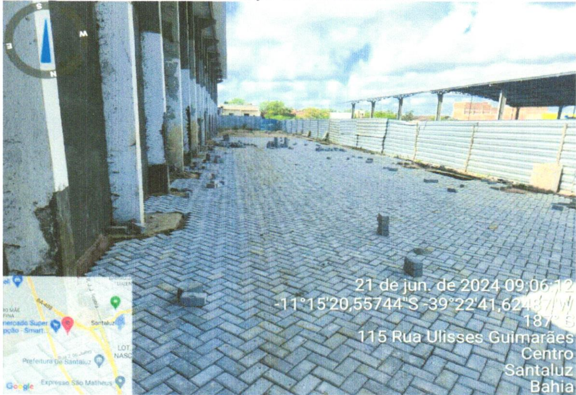
FOTO 38- EXECUÇÃO DE PISO INTERTRAVADO
