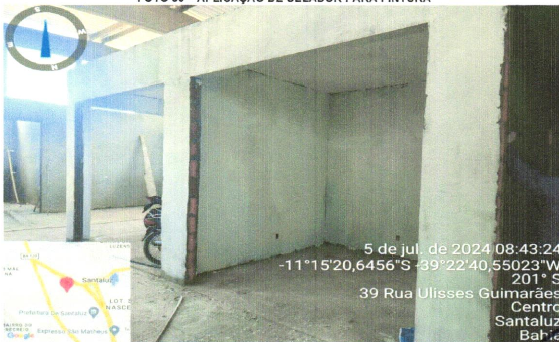
FOTO 30 - APLICAÇÃO DE SELADOR PARA PINTURA
