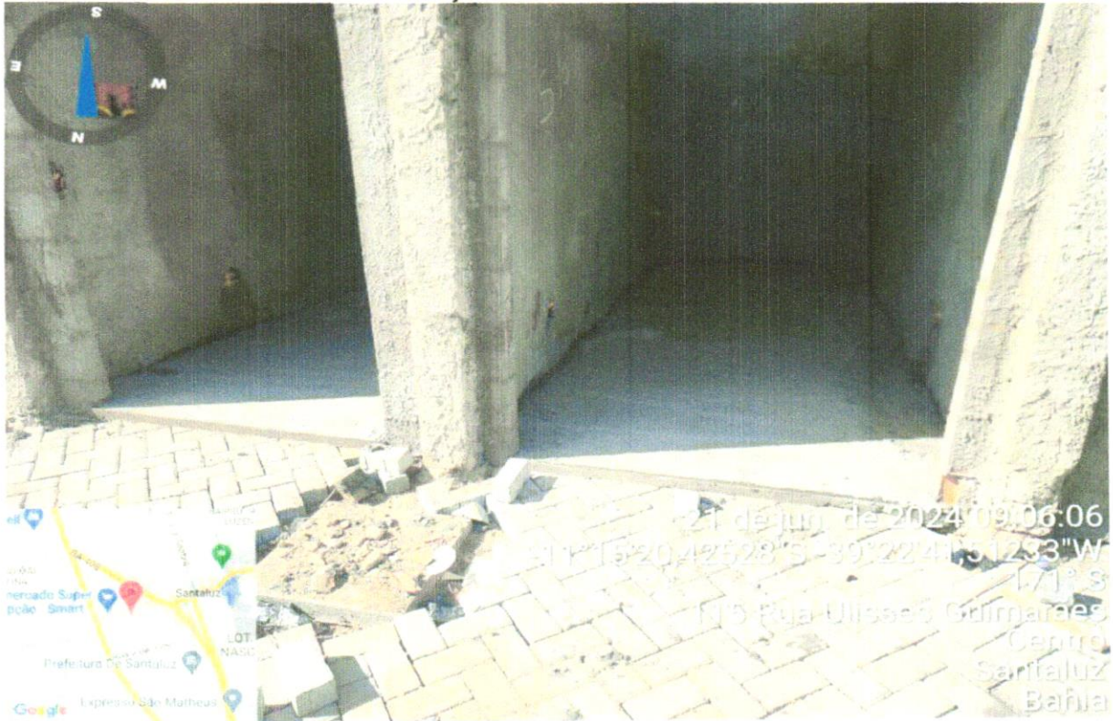
FOTO 14 – EXECUÇÃO DE PISO CONCRETO ARMADO
