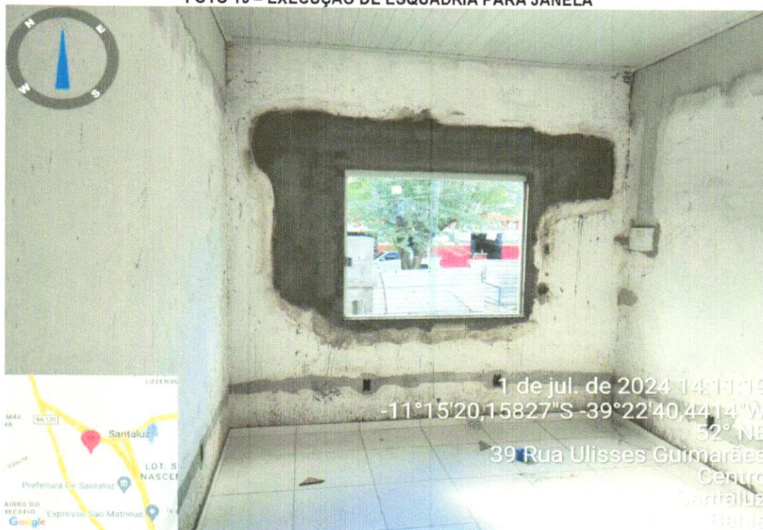
FOTO 20 – EXECUÇÃO DE ESQUADRIA PARA JANELA
