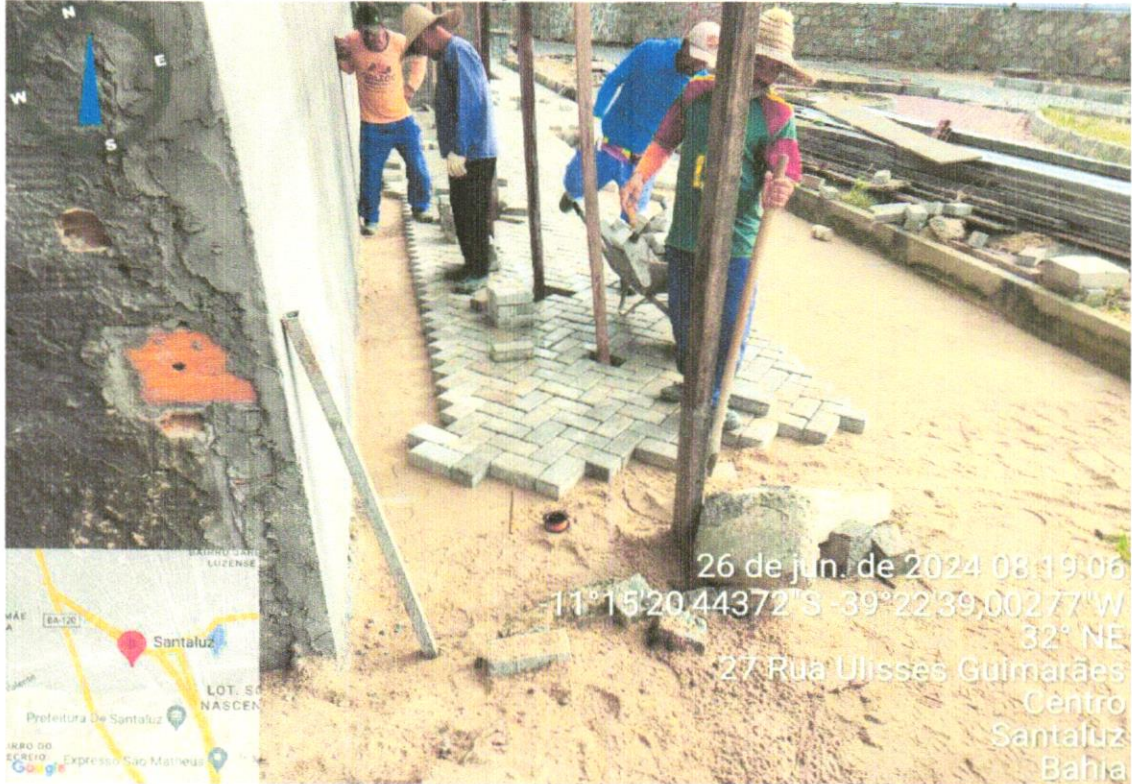
FOTO 40- EXECUÇÃO DE PISO INTERTRAVADO
