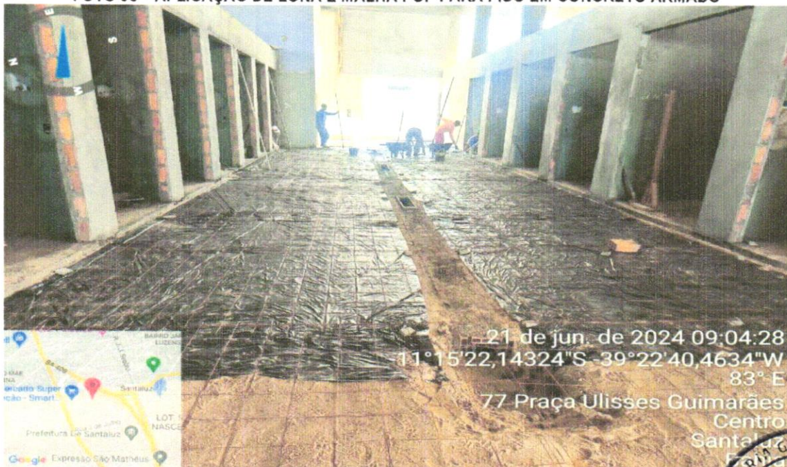
FOTO 06 – APLICAÇÃO DE LONA E MALHA POP PARA PISO EM CONCRETO ARMADO
