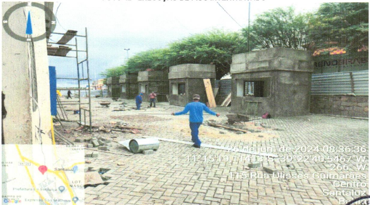
FOTO 42- EXECUÇÃO DE PISO INTERTRAVADO
