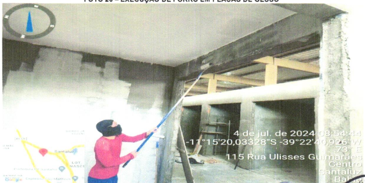
FOTO 26 – EXECUÇÃO DE FORRO EM PLACAS DE GESSO
