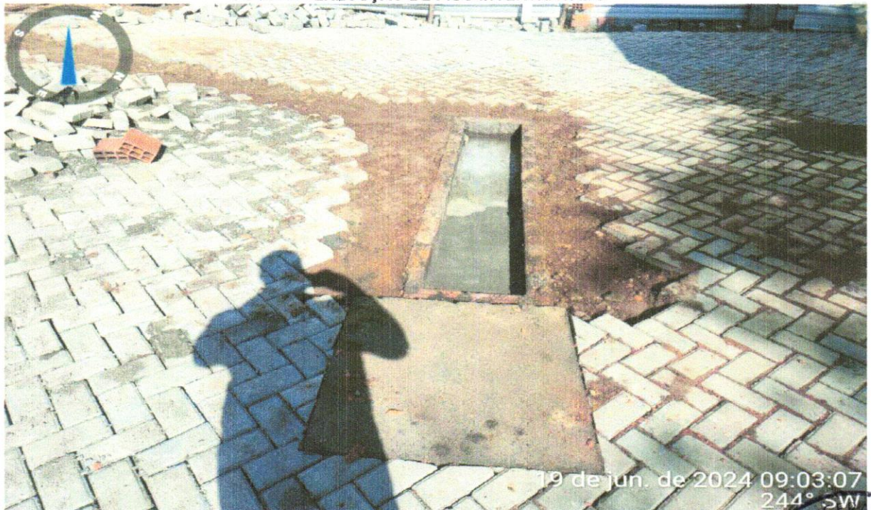
FOTO 44- EXECUÇÃO DE PISO INTERTRAVADO
