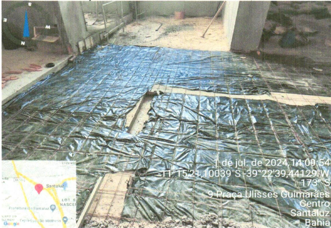
FOTO 04 – APLICAÇÃO DE LONA E MALHA POP PARA PISO EM CONCRETO ARMADO
