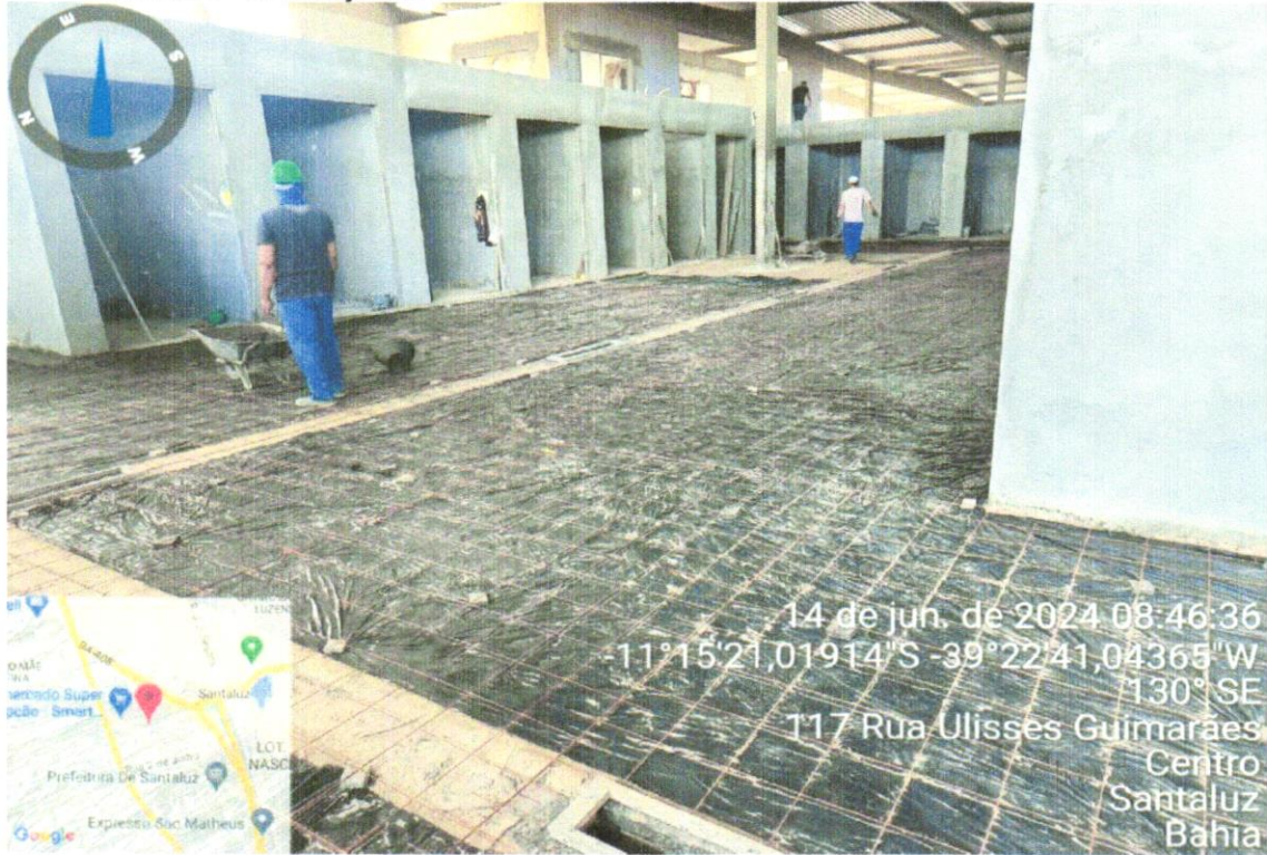
FOTO 06 – APLICAÇÃO DE LONA E MALHA POP PARA PISO EM CONCRETO ARMADO
